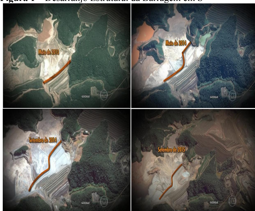
Figura 1 – Desarranjo Estrutural da Barragem em S
